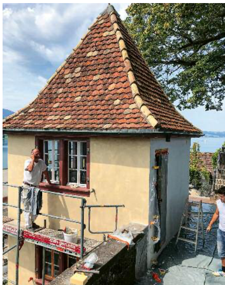
Auftrag des neuen Kalkputzes.
