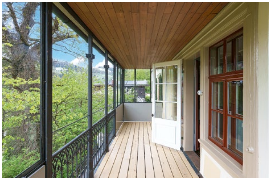
Die filigrane Balkonkonstruktion gegen das Tal hin wurde aufgefrischt und mit neuen Holzoberflächen im Bodenbereich versehen.
