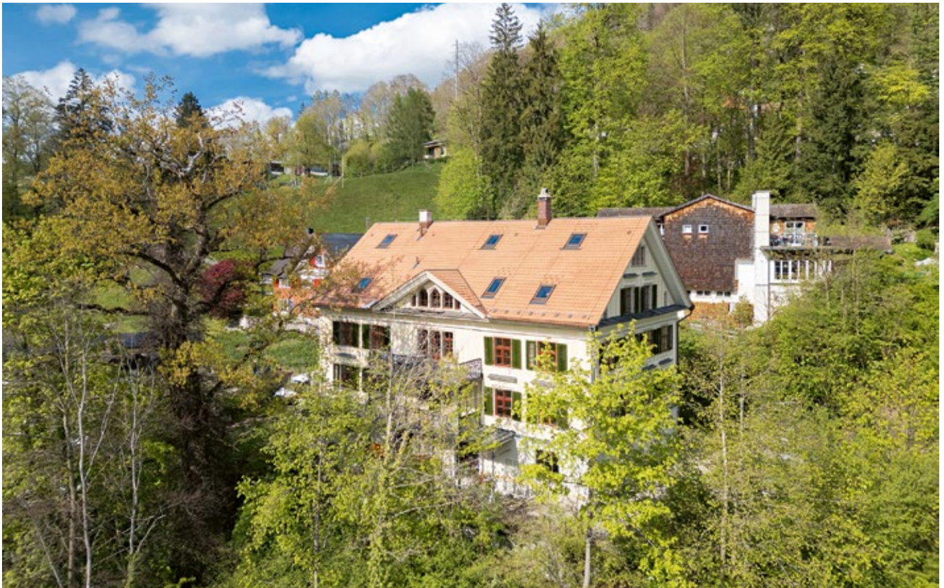
Das stattliche Gebäude erstrahlt nach der Sanierung in neuem Glanz und trägt durch die behutsame Instandstellung der historischen Bausubstanz zu einer nachhaltigen Ortsentwicklung bei. Die Dachflächenfenster stammen bereits von früheren Umbauten.
