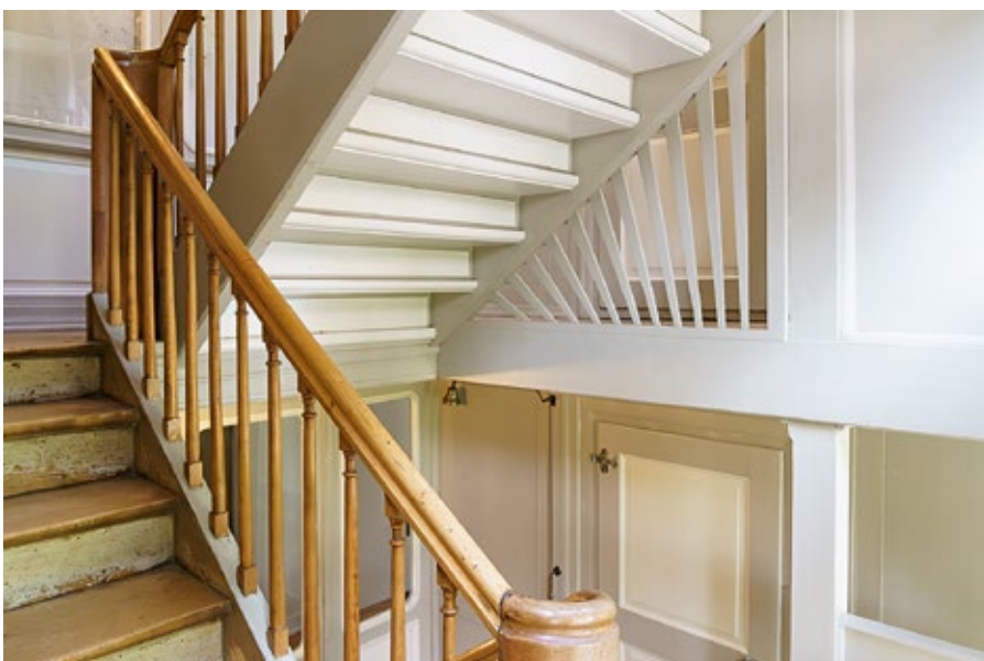
Das Treppenhaus wurde zurückhaltend instand gestellt, für den Brandschutz konnten einvernehmliche Lösungen gefunden werden.
