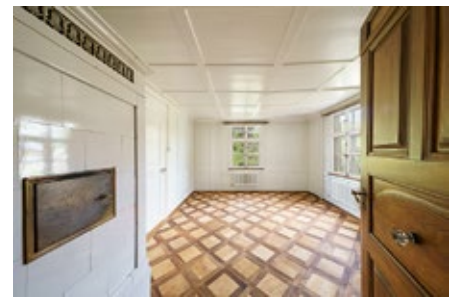
Die bauzeitlichen Einbauten und Oberflächen wurden sorgfältig restauriert, der Kachelofen dient immer noch als Wärmequelle.
