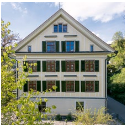
Die Fassaden wurden in ihrer historischen Bausubstanz instand gestellt und mit Ölfarbe gestrichen; die Handwerker verfügten über die Zusatzausbildung «Handwerk in der Denkmalpflege».
